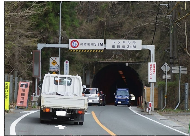
幅員狭小のため、すれ違いを待つ車輛
