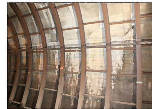
補強のため設置された鋼製支保工
